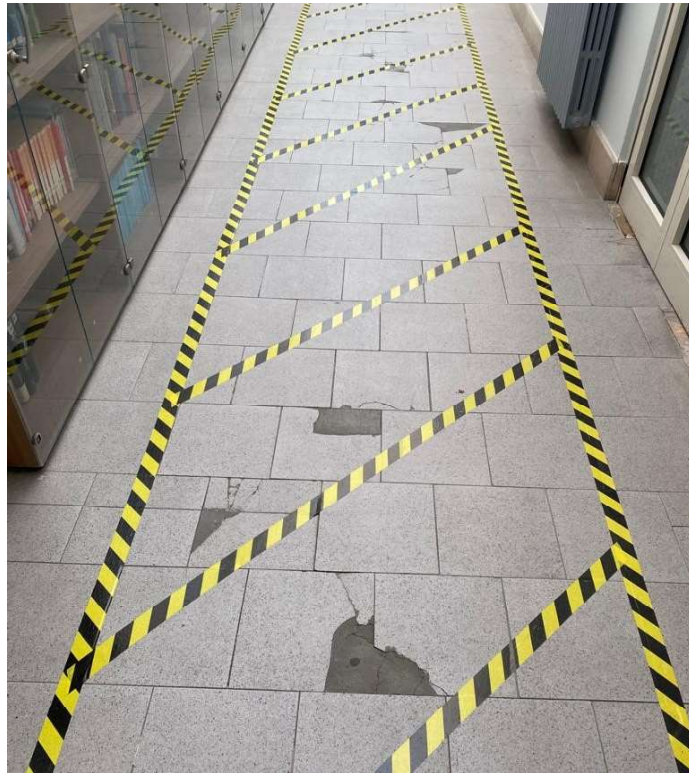
Figura 12 - Corridoio: dettaglio pavimentazione
