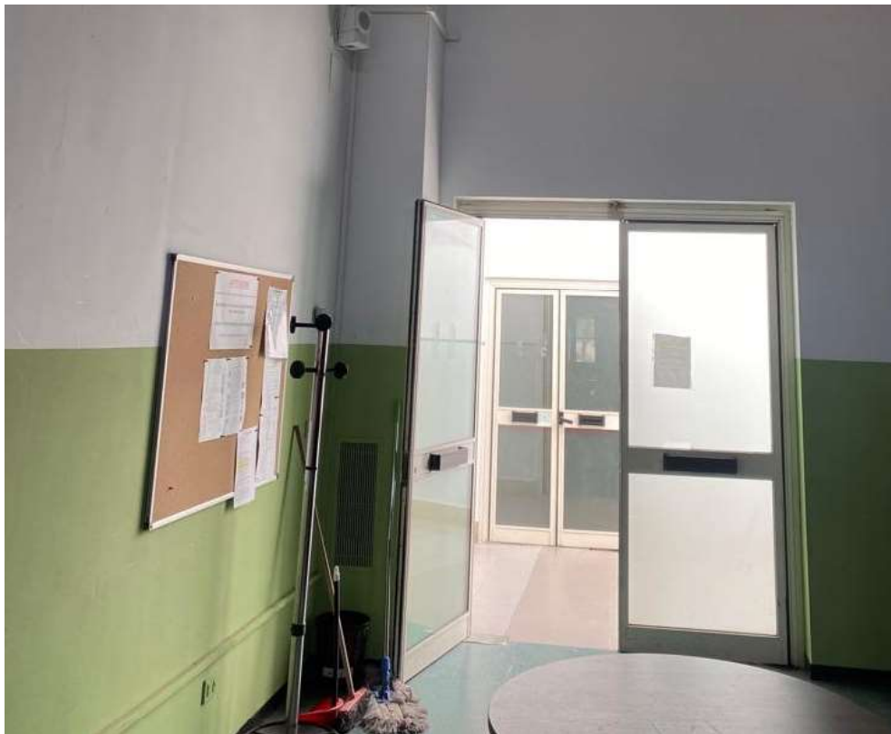
Figura 5 - Aula AC1: porta ingresso
