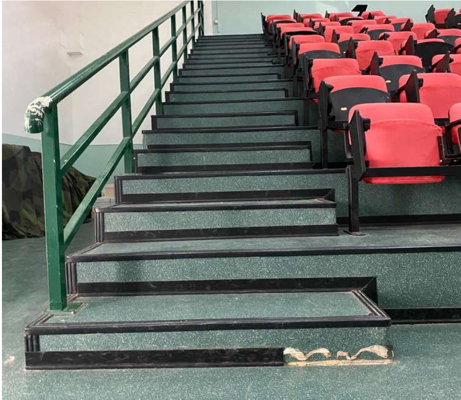
Figura 8- Aula BC1: dettaglio pavimentazione
