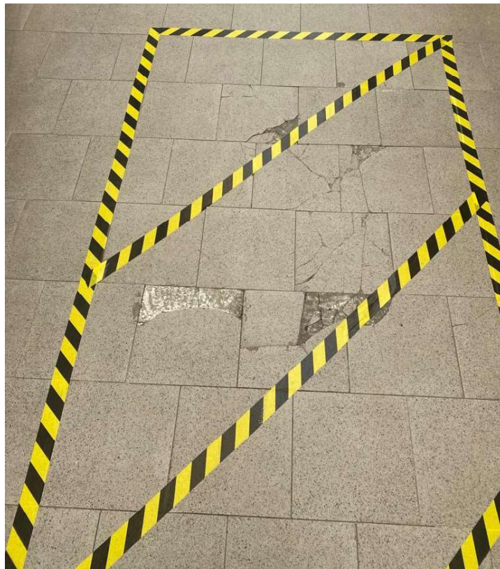
Figura 13 - Corridoio: dettaglio pavimentazione
